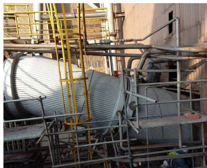
▲ Cooling Hood 및 Duct 교체 공사
